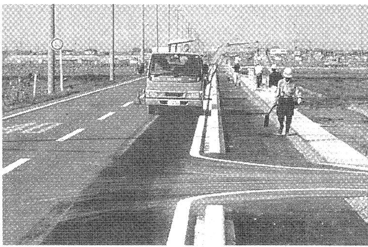
拡幅された村道。約400メートル離れて並行して広域農道が建設される計画。立田村で
